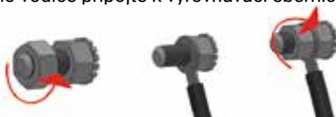
Obrázek 3. Připojení zařízení ke svorkovnici pro vyrovnání elektrických potenciálů.
